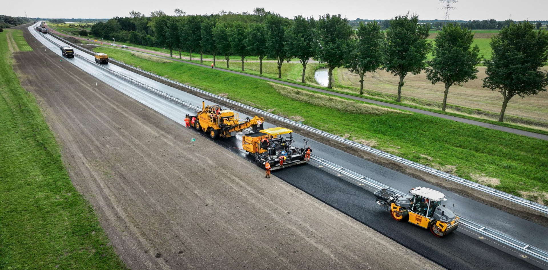
HEIJMANS DE VERBINDINGSWEG N59 TUSSEN ZEELAND EN ZUID-HOLLAND VERBREED.
